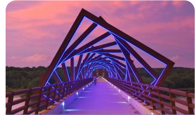
High Trestle Trail Bridge • Des Moines, IA
